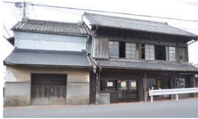
旧平井家住宅〔佐倉市新町 233-5 (店舗兼主屋、座敷棟、脇蔵)〕
