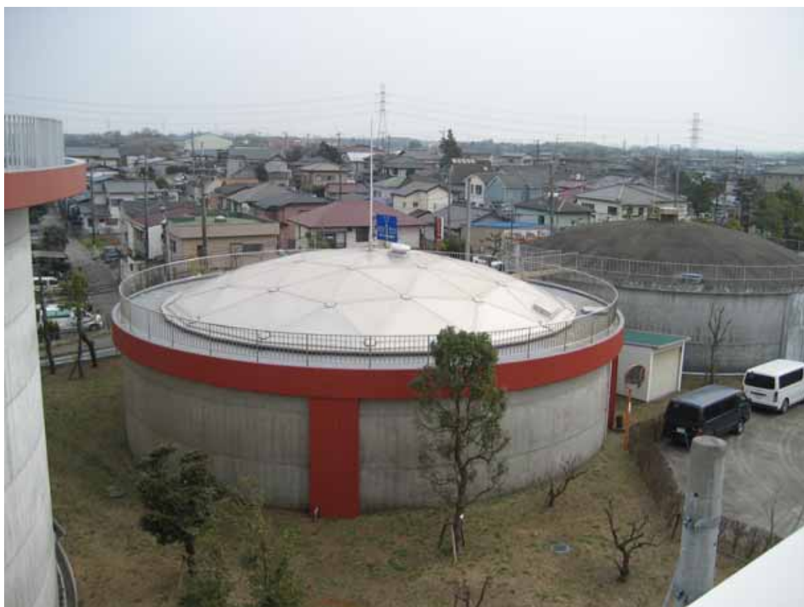
志津浄水場 2 号配水池（アルミドーム屋根）
