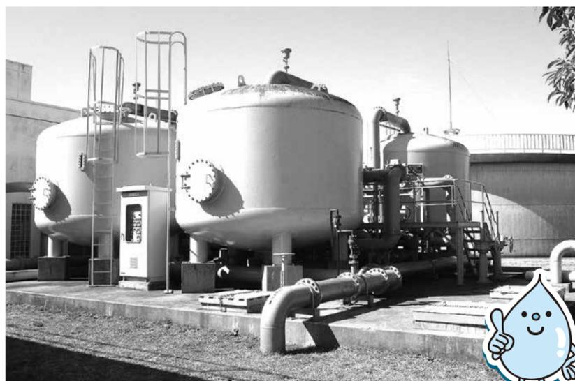
▲改修を予定している志津浄水場の除鉄・除マンガン装置 ※1
