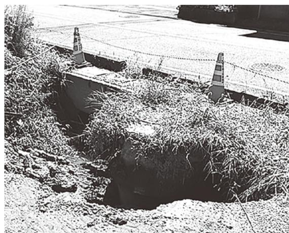
老朽化した下水道管の破損による陥没
