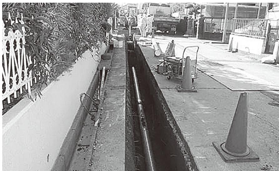
口径75mm HPPE(高性能ポリエチレン管)への交換による耐震化工事
