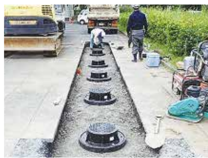
災害用マンホールトイレ整備工事の様子(臼井南中学校)
