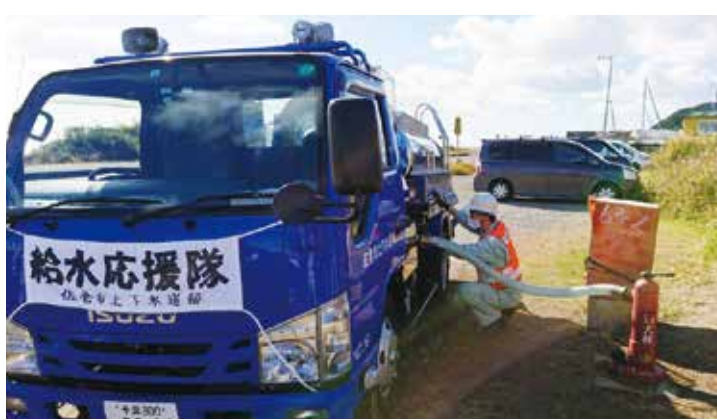
消火栓からの補水作業の様子
