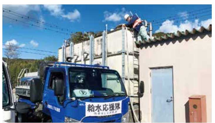
社会福祉施設の受水槽への補給作業の様子
