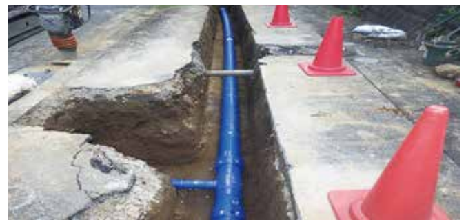
水道管耐震化工事の様子
