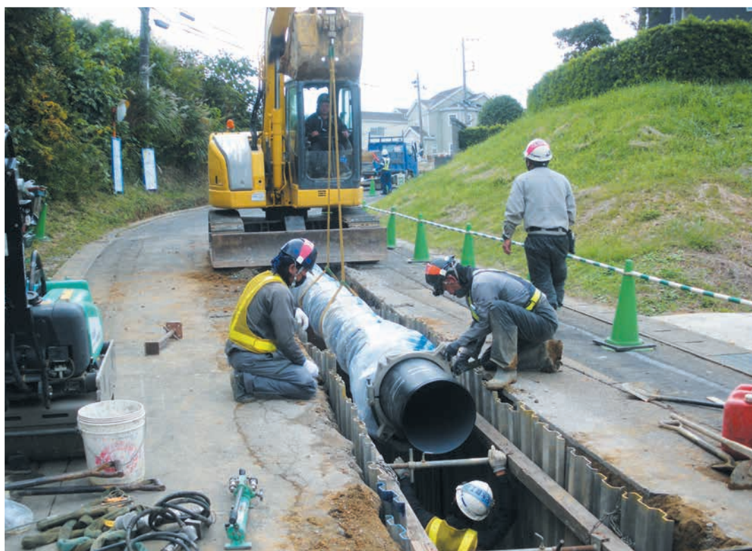
耐震化工事の様子
