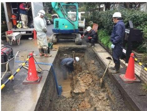
図4-10 水道漏水復旧工事
