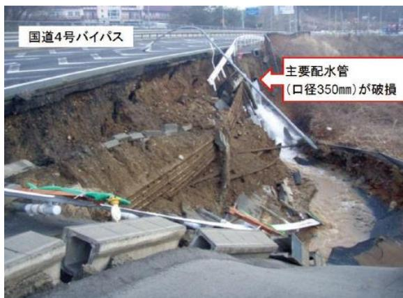
図4-4 東日本大震災で破損した水道管
