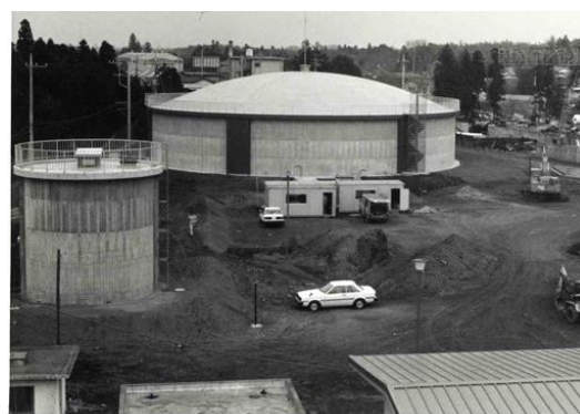
図2-2 完成間近の南部浄水場配水池
