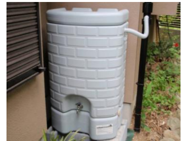
図2-24 雨水貯留施設
