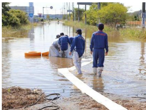
図4-5 大雨により冠水した道路 (国道296号 鹿島橋付近)
