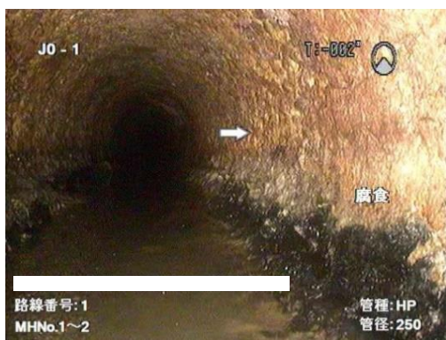
図4-12 TVカメラによる管渠調査
