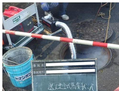
図4-13 不明水対策(送煙調査)
