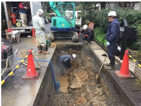
図4-10 水道漏水復旧工事
