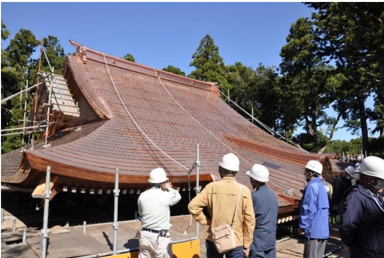
1-6 その他の歴史的建造物の保存整備 (密蔵院薬師堂修復)
