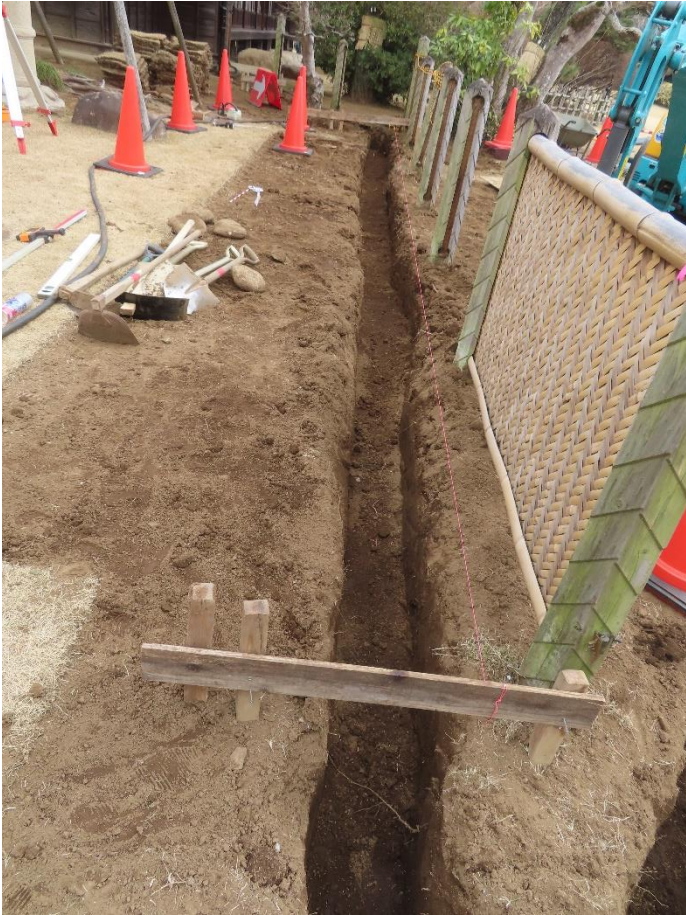
網代垣の内側に排水施設を設置
