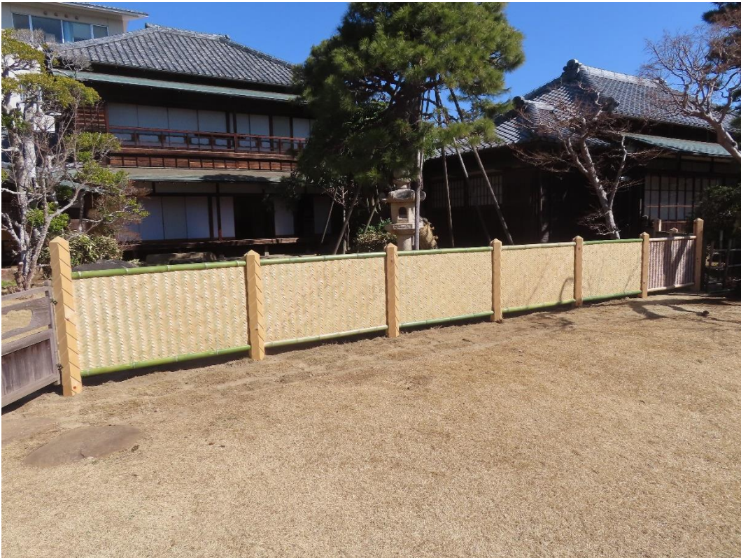
網代垣修理後（令和7年度は東側、令和8年度に西側を修理予定）
