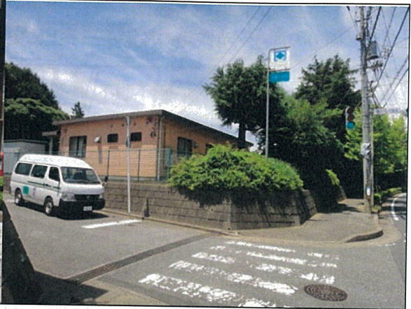
井野小学校北側進入路
