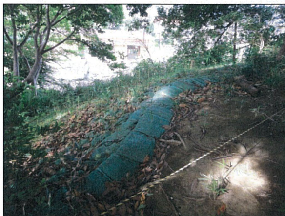
学校地区北側の崩落防止状況
