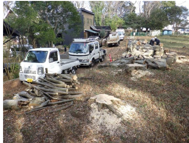
赤道脇伐採後（南西から）
