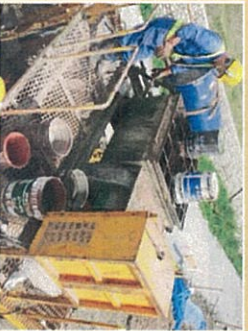
アスファルト混合状況
