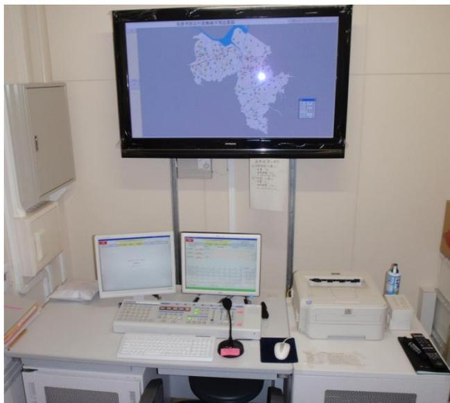
市役所に設置する制御卓（親局）で音声を録音し、市内の防災行政無線スピーカー（子局）から放送するものです。
