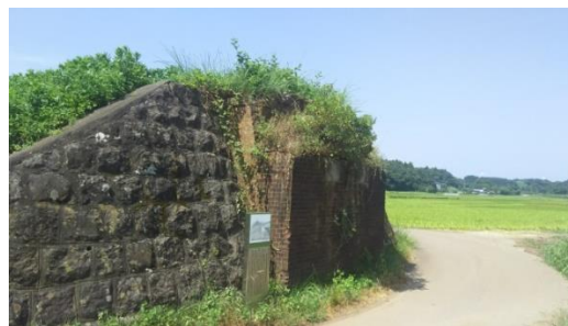
総武鉄道物井川橋梁亀崎橋台跡
