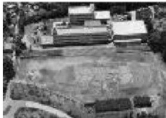
【 内郷小学校全景 B棟 】
