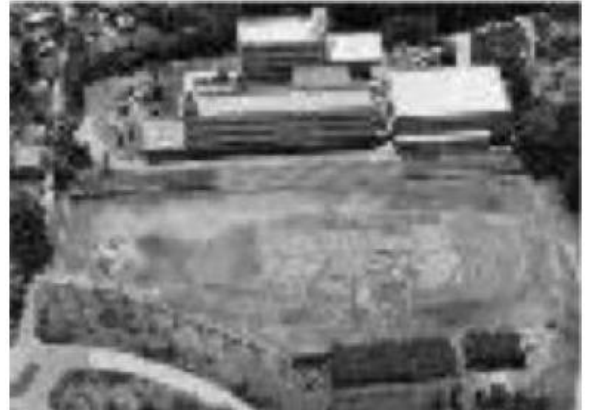
【 内郷小学校全景 B棟 】
