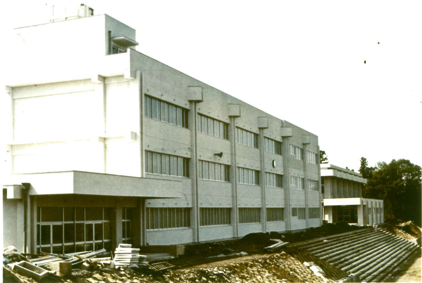
2万4216㎡の敷地に新築された校舎、体育館も同時に完成
