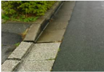
写真 がいきよ 街渠
